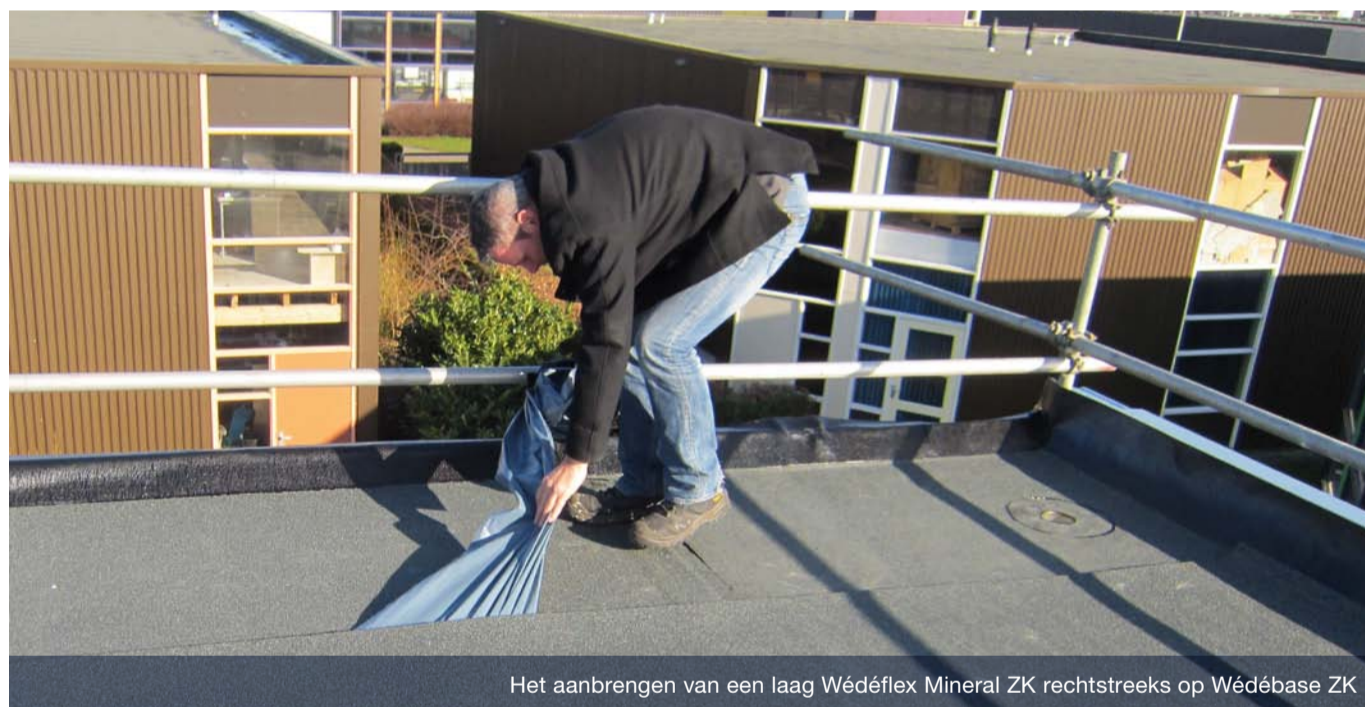
Een gereed dak, gemaakt met Wédébase ZK en Wédéflex Mineral ZK
