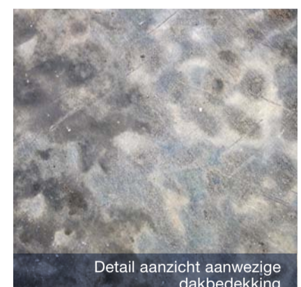
Aanzicht aanwezige dakbedekking
