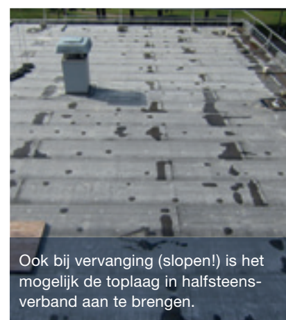
Uitvoeringstechnisch wordt bij vervanging (slopen!) veelal gekozen te werken in blokverband met sluitbanen.
