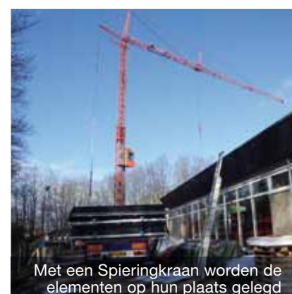
De elementen worden geplaatst op de gelamineerde houten spanten
