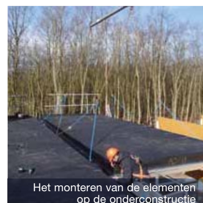
Met een Spieringkraan worden de elementen op hun plaats gelegd
