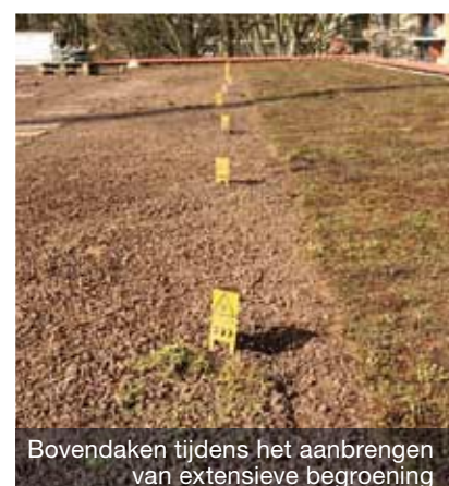
Bovendaken tijdens het aanbrengen van extensieve begroening
