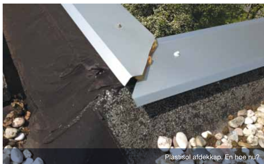
Bouwkundig detail onvoldoende opstandhoogte
