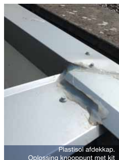
Inplaktrim als ontworpen en gebogen aangebracht
