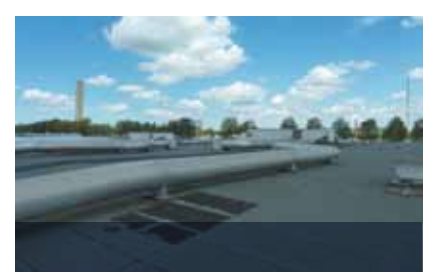
Aanbrengen dakbedekking dakrand
