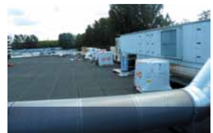
Aanbrengen toplaag Wédéflex D4
