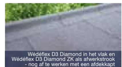
Resterende werkzaamheden betreft de dakrandverhoging en -afwerking
