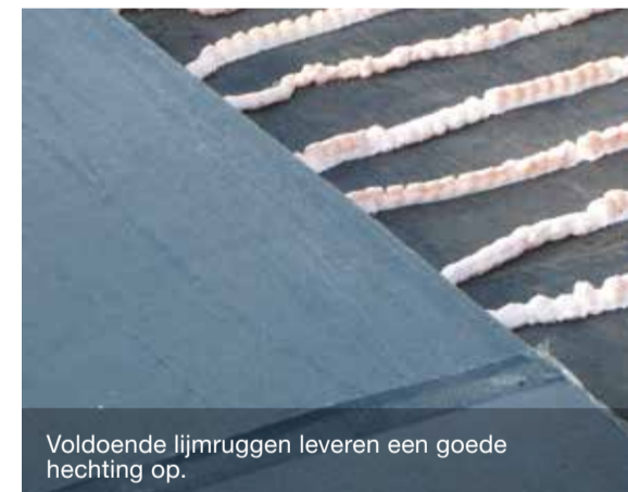
Het aanbrengen van de PU-lijm in de praktijk, rand- en hoekzones krijgen extra lijmruggen.
