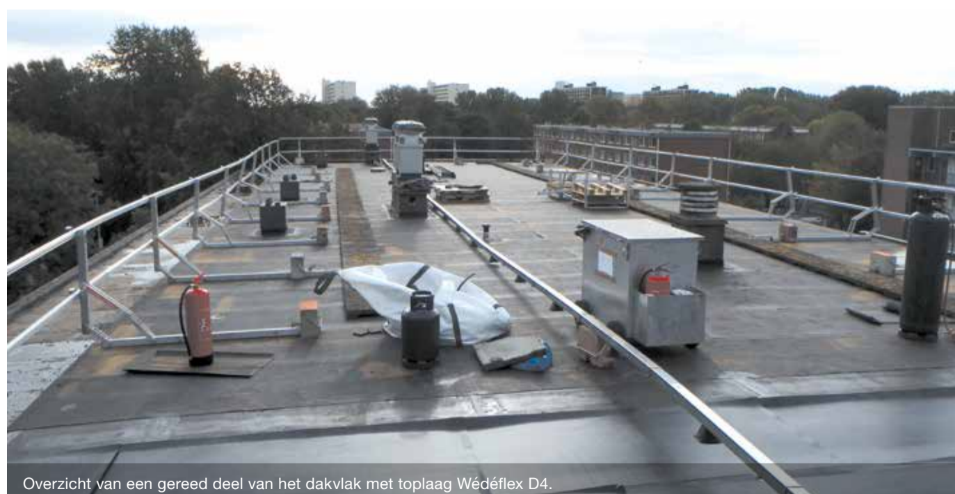
Een dichtgelegd deel van het dakvlak met Unidek Wédé-Blackpearl.
