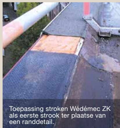
Een demonstratie van het aanbrengen overlapaansluiting van Wédémec ZK.
