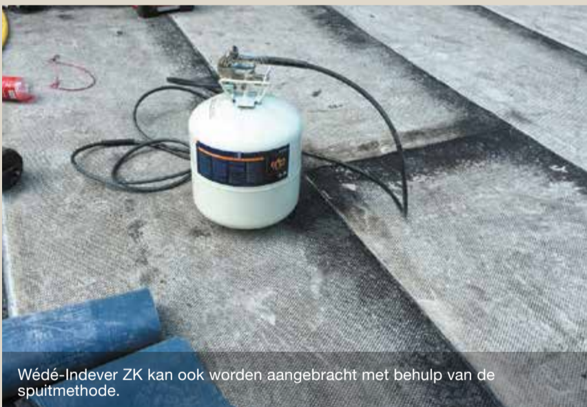
Het aanbrengen van Wédé-Indever ZK op de bouwkundige ondergrond.
