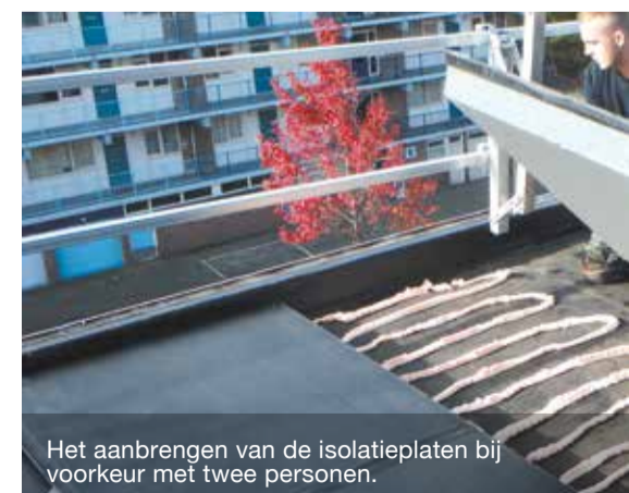
Voldoende lijmruggen leveren een goede hechting op.
