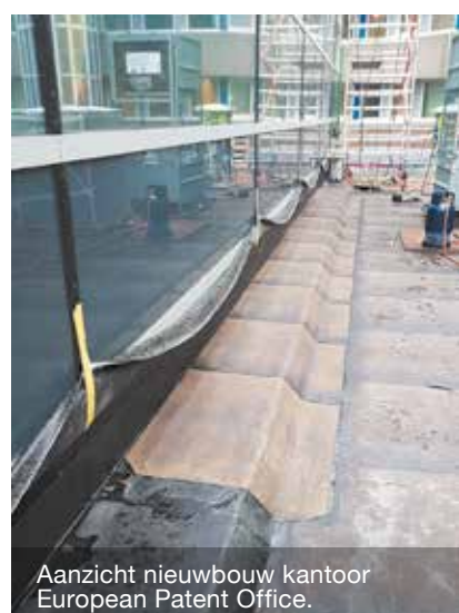
Aangebrachte toplaag Wédéflex D4.
