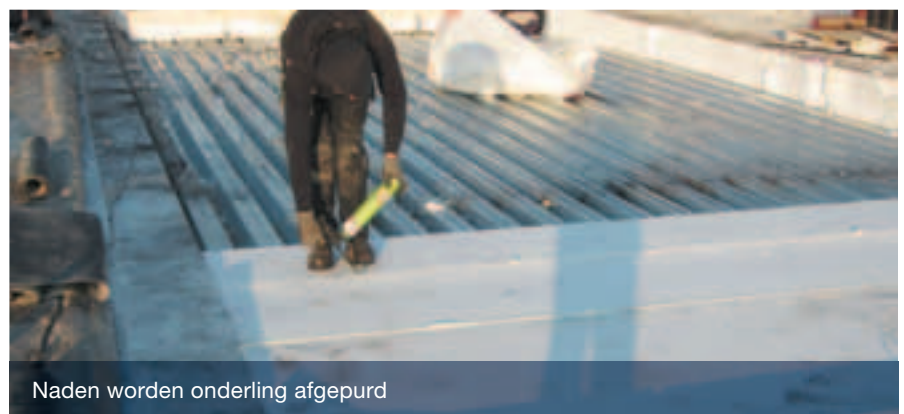
Nieuwe isolatie in drie lagen, met onderling verspringende naden aangebracht
