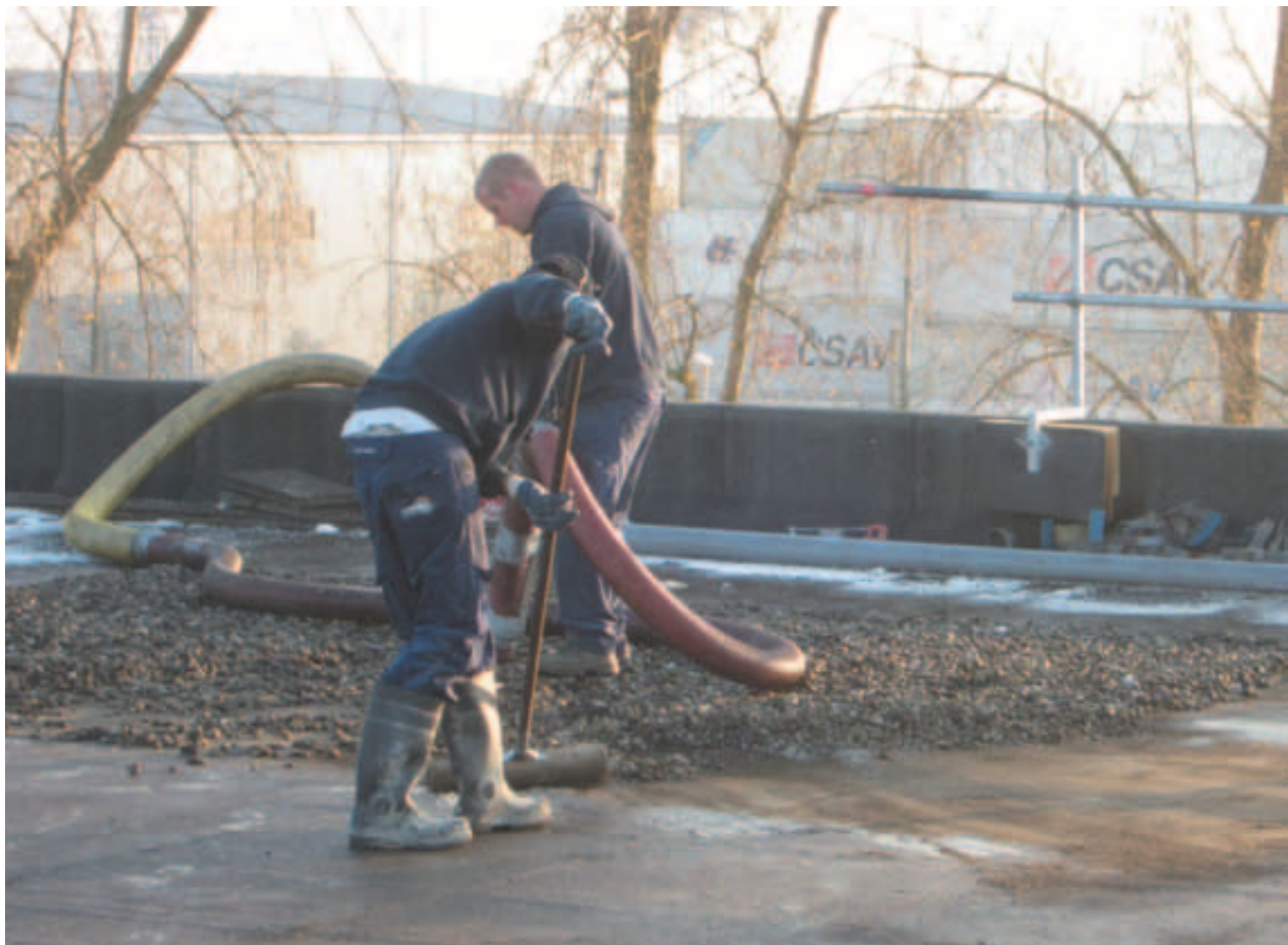
Ballastgrind wordt afgezogen
