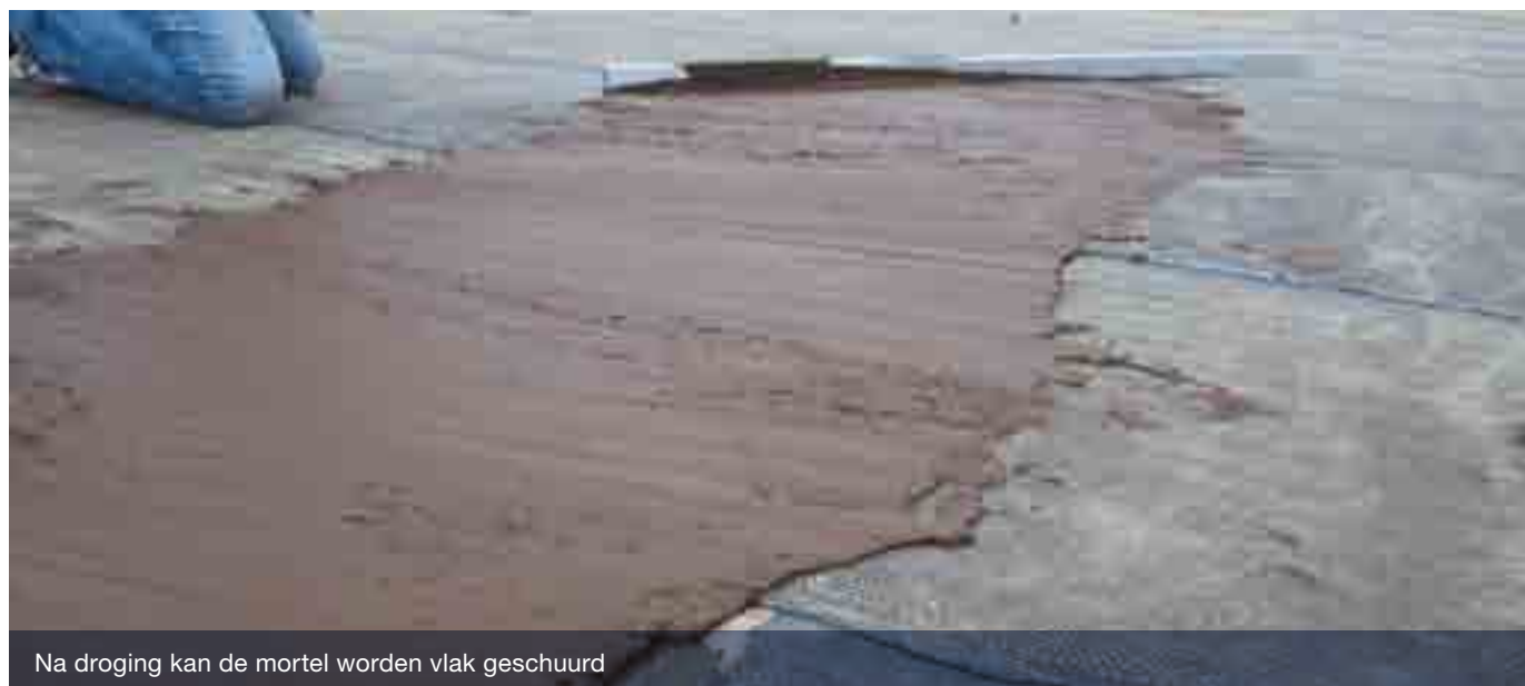
De mix met metalen rei vlaktrekken
